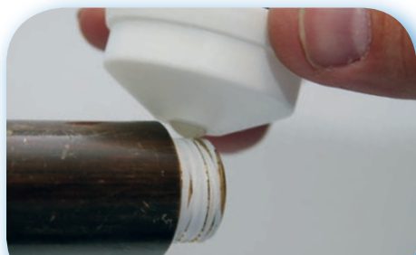
2-3 Tropfen des Gleitmittels (in herausnehmbarem Boden) auf den Dichtfaden geben - biologisch abbaubar
