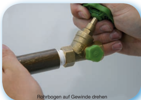
Rohrbogen auf Gewinde drehen
