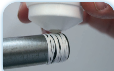
2-3 Tropfen des Gleitmittels (in herausnehmbarem Boden) auf den Dichtfaden geben - biologisch abbaubar
