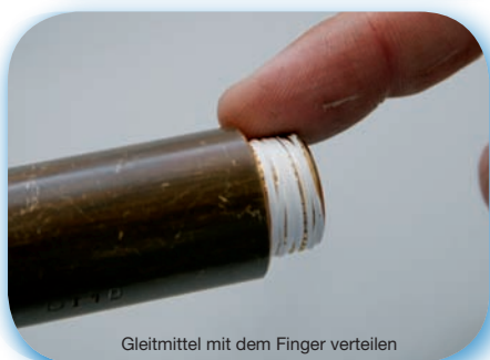
2-3 Tropfen des Gleitmittels (in herausnehmbarem Boden) auf den Dichtfaden geben - biologisch abbaubar
