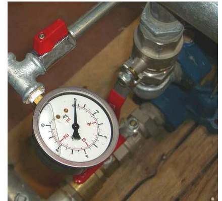
Abb. 5: Austausch des Druckmessers am Zulauf durch den Druckmesser
